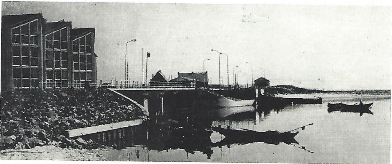
Een gedeelte van het gemaal „Colijn”. Op de voorgrond de zuigkanalen, waardoor het water naar de pompen wordt gevoerd. De capaciteit van het gemaal, dat over drie elektrische pompen beschikt, bedraagt 1580 m 3 /min.
