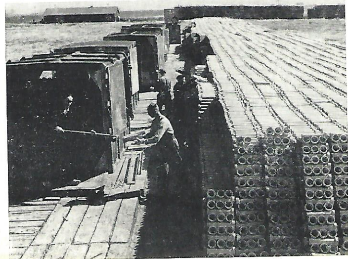
Draineerbuizen worden gelost. Men is reeds bezig deze buizen aan te brengen ter ontwatering van de grond.
